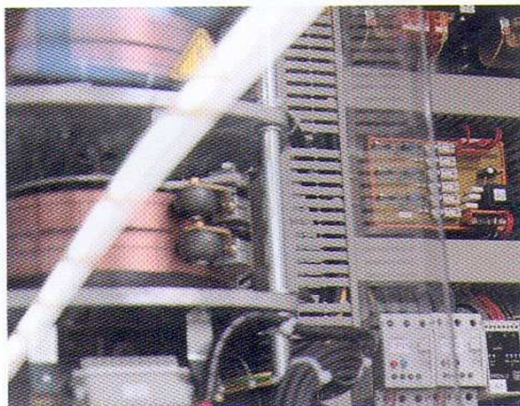
Regelanlagen reduzieren über Schütze oder Ringstelltransformatoren automatisch die Arbeitsspannung und helfen so Energiekosten sparen
